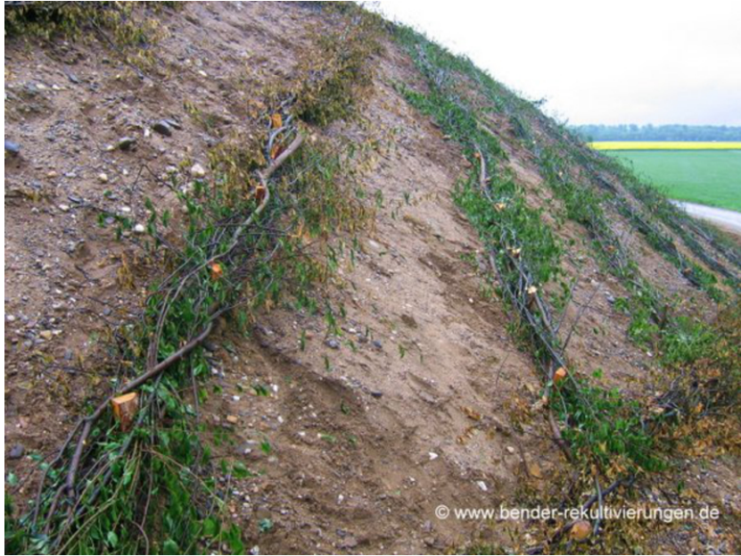
Figure 12-12. Live Fascines ( http://www.bender-rekultivierungen.de/en/services/bioengineering/ )
