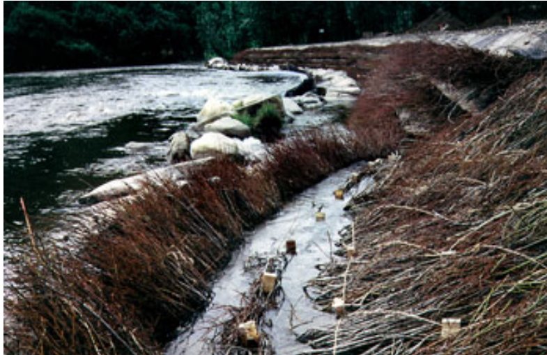
Figure 12-7. Live Siltation
